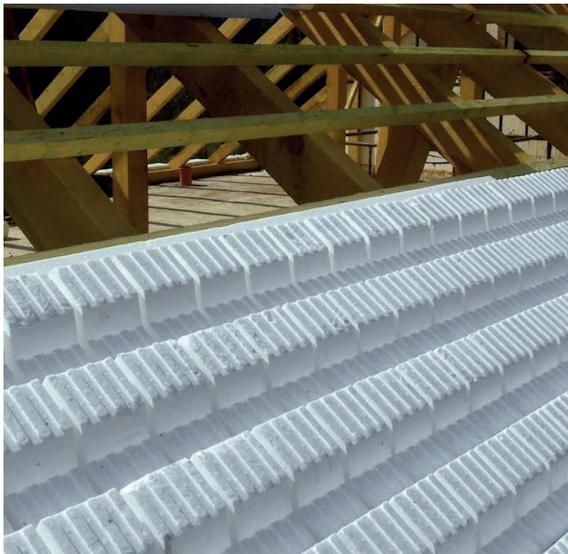
Die kleinen Kanäle ermöglichen eine flächendeckende Abführung des Kondensats und des Wassers.
