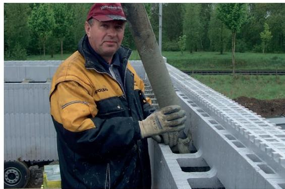
Bei der Betonverlegung mit einer Übergabeschnelligkeit von 6-9 m<sup>3</sup>/h können Wände von 40 bis 70 m<sup>2</sup> sogar innerhalb 1 Stunde aufgefüllt werden.
